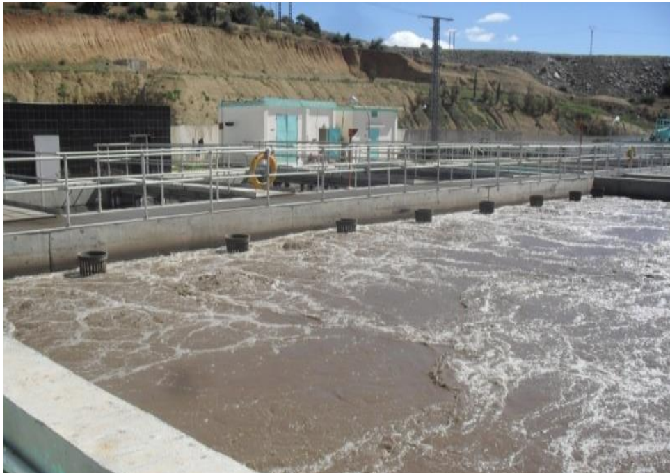
Figure III.4 : Bassin d'aération
