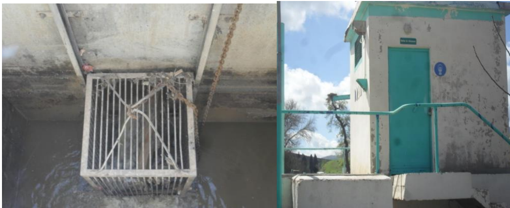
Figure III.1: dégrilleur grossier
