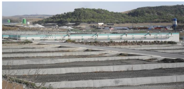
Figure III.8: Les lits de séchages
