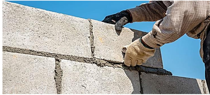
Figure I. 3 : Pose de mortier de hourdage.
