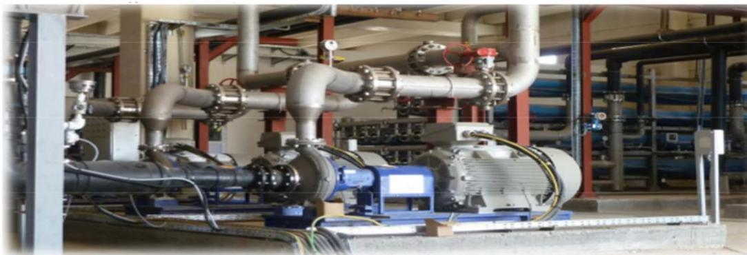
*Fig. V 22 : Pompes de haute pression de la station.*
