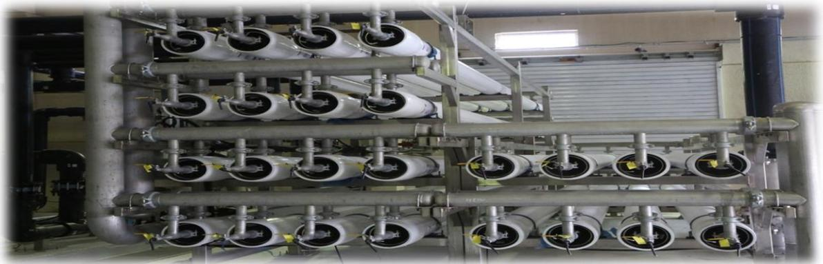
Fig. V 23 : le placement des membranes de la station par étage.
