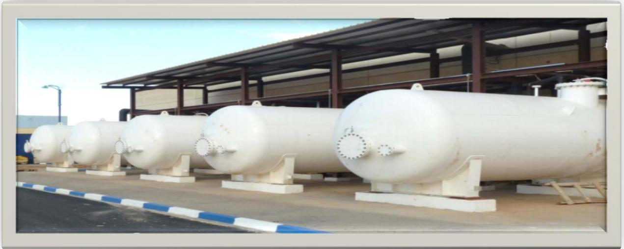
*Fig. V 14 : les 5 filtres de la station.*
