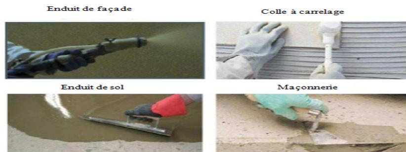
**Figure II. 2:** application des mortiers [41].
