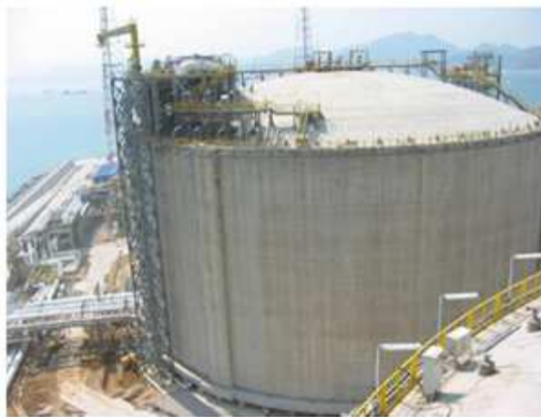
Figure (I-9-b) : réservoir aériens à intégrité totale. [12]
