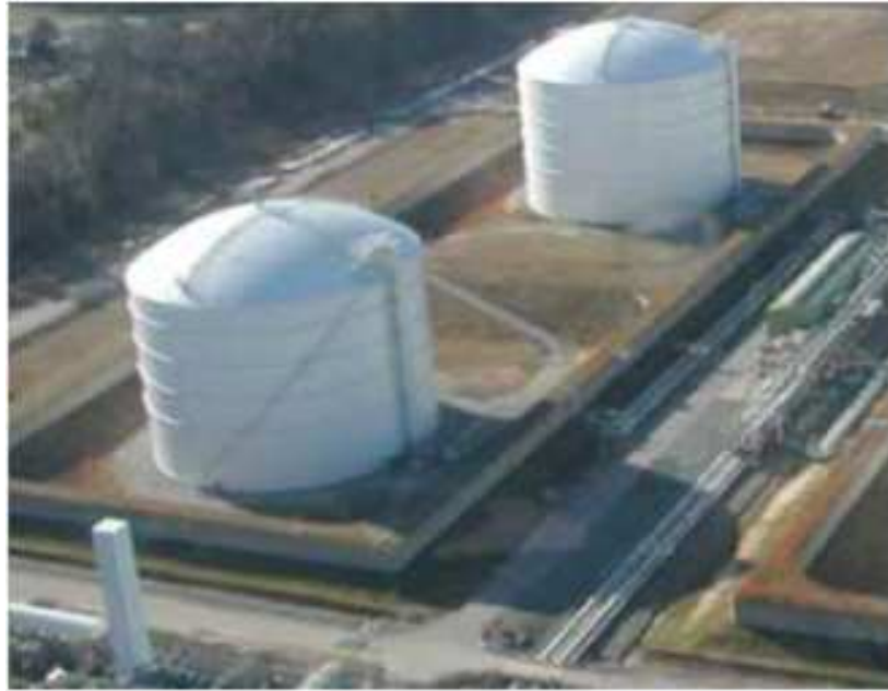
Figure (I-5-b) : réservoir aérien à simple intégrité. [12]
