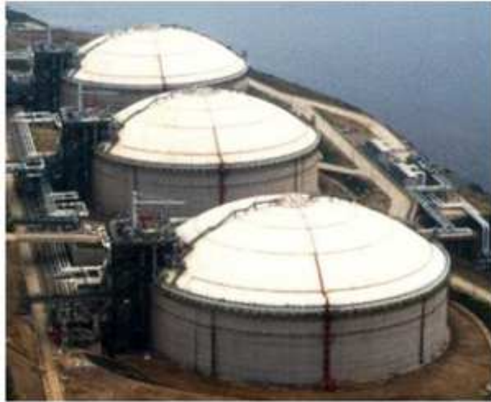
Figure (I-6-b) : réservoir aérien à double intégrité. [12]
