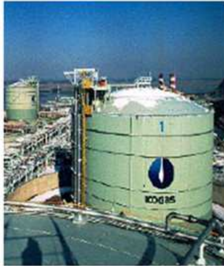
Figure (I-7-b): réservoir aérien de type membrane. [12]
