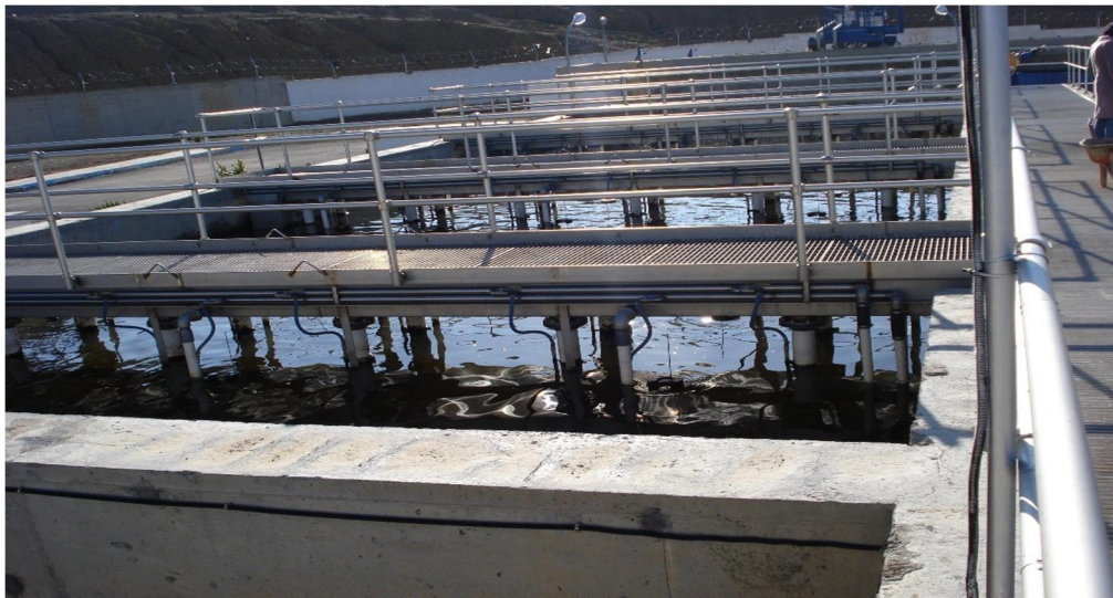
Figure I.8 : Clarificateur
