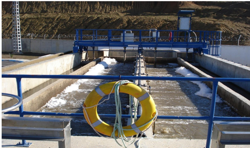
Figure I.6 : Dessablage / Déshuilage
