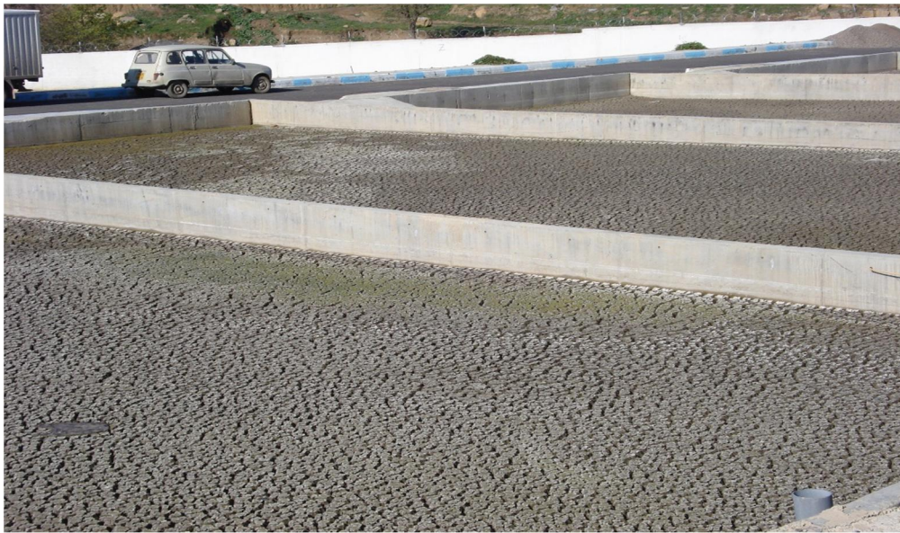
Figure I.11 : Les lits de séchage.
