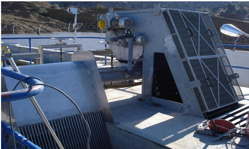
Figure I.5 : Dé grilleur (Manuel / Automatique).
