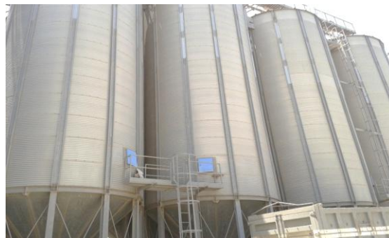
Figure 2 : silo de stockage de blé sale
