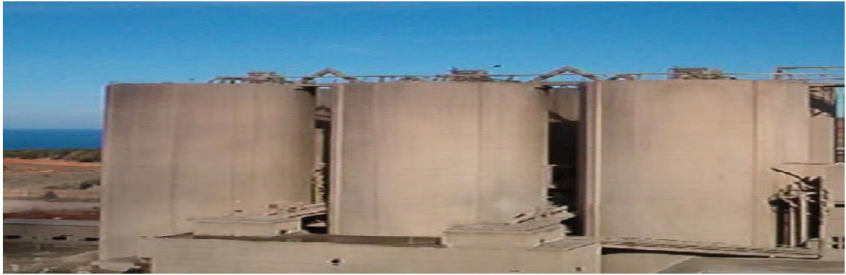
Figure I. 12 : Silos de stockage de ciment [24].
