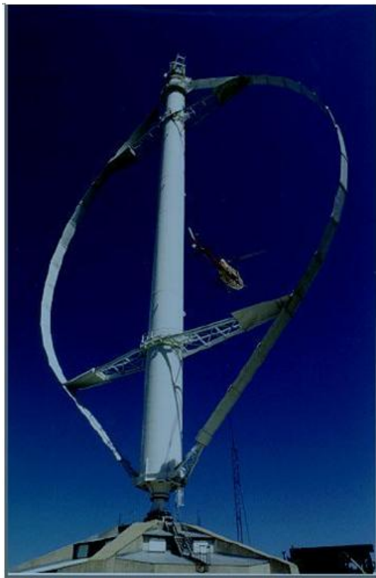
Éolienne de type Darrieus.
