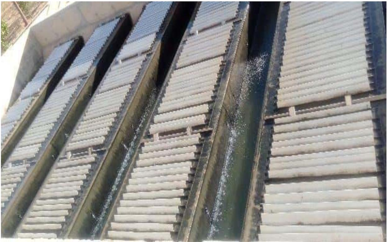
**Figure II-5:** Décantation lamellaire
