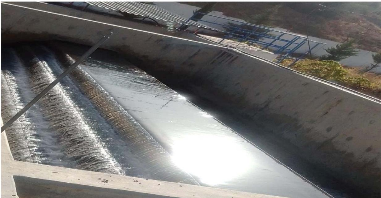
**Figure II-2:** Cascade d'aération
