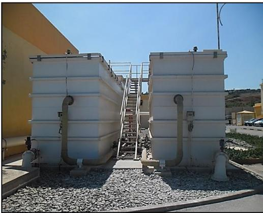
Figure III- 14: Saturateur de chaux
