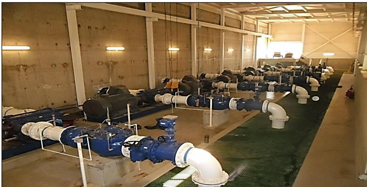
Figure III- 16:Station de pompage de l'eau traitée
