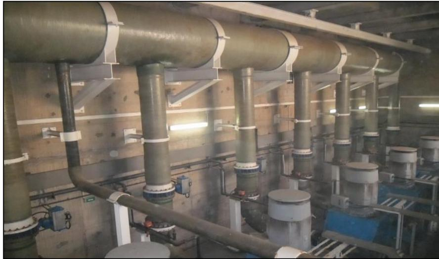
Figure III- 3: Station de pompage de l'eau brute
