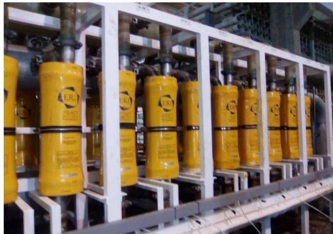
Figure III- 11:Echangeur de pression ERI utilisé à l'usine
