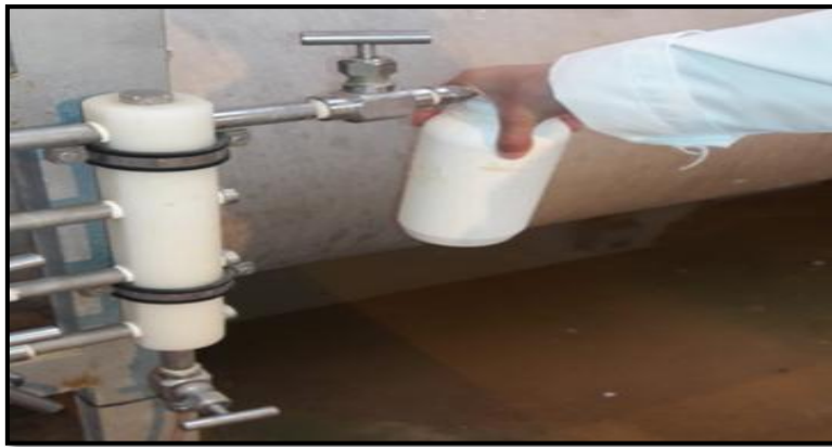
Figure III.2 : point de prélèvement de l'eau produite.
