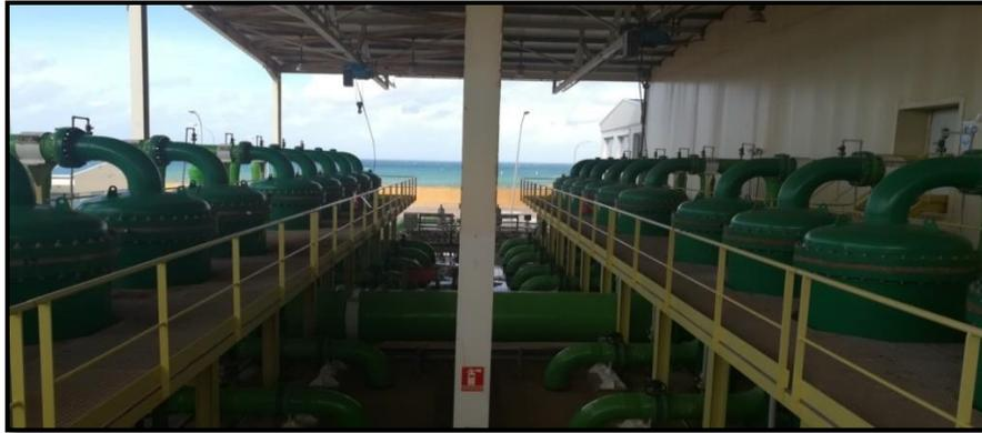
**Figure II-10:**Filtres à cartouche au niveau de la station UTE Desaladora-Ténès
