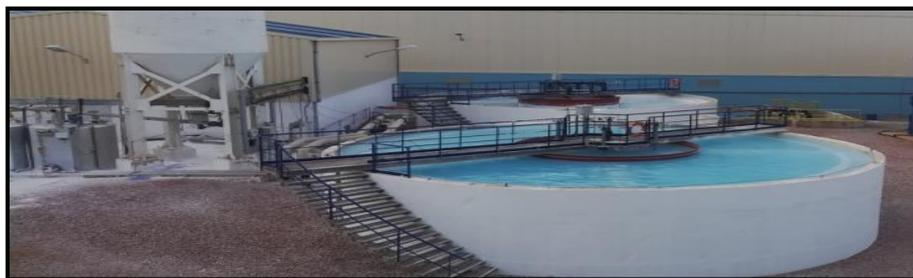
Figure II-12: Système du dosage et saturation de la chaux
