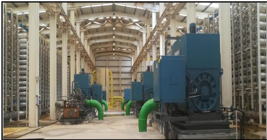
**Figure II-11:** Installation d'osmose inverse
