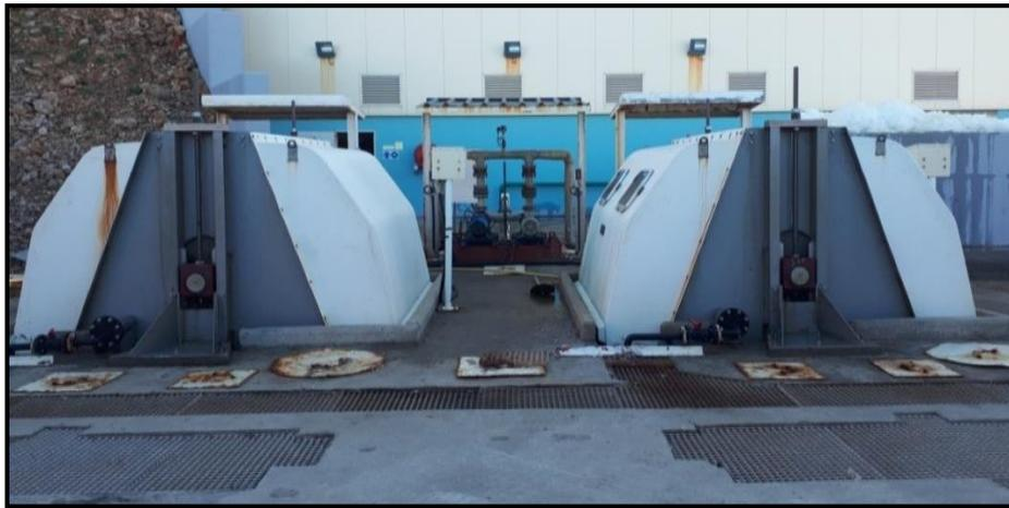
Figure II-6: Filtres fin rotatifs (Baudry)
