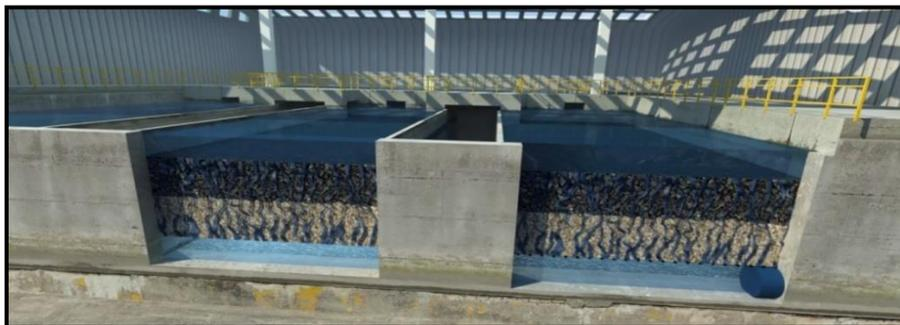
**Figure II-9:** Filtres à sable au niveau de la station UTE Desaladora-Ténès
