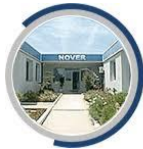
Figure I . 1: l'entreprise NOVER de Chlef [3].
