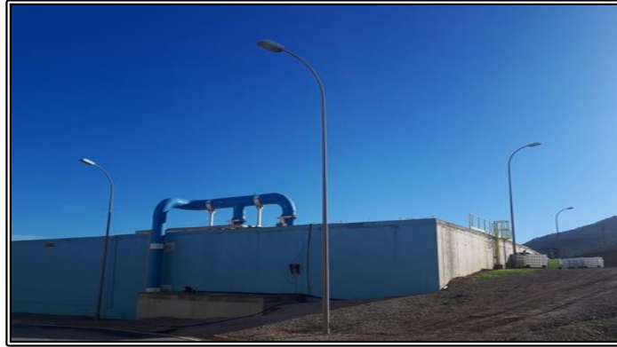
Figure II.19: Réservoir de stockage de l'eau produite.
