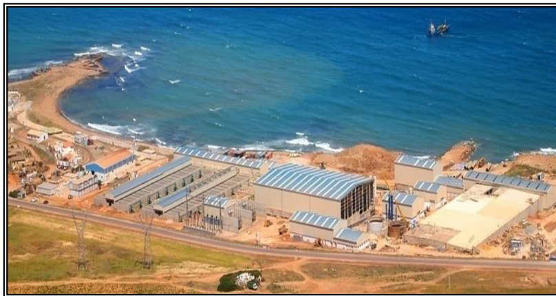
Figure I.11: Vue générale sur la station de Ténès
