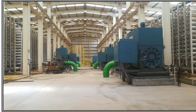
Figure II.12: Bâtiment d'osmose inverse.
