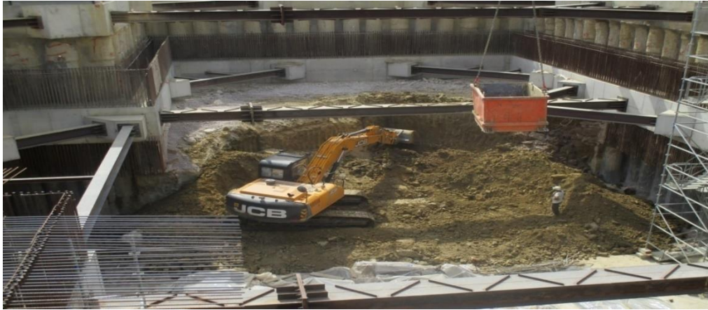
Figure II.1 : Creusement à ciel ouvert (tranchées ouvert).
