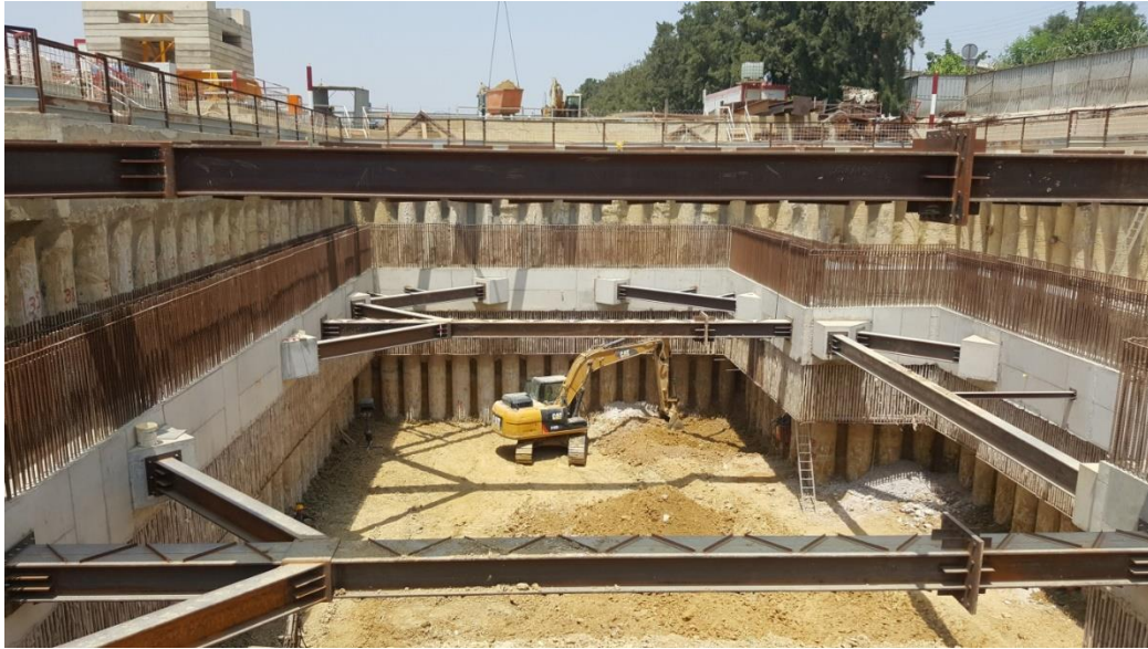
Figure II.6 : Pieux avec des buttons [1].
