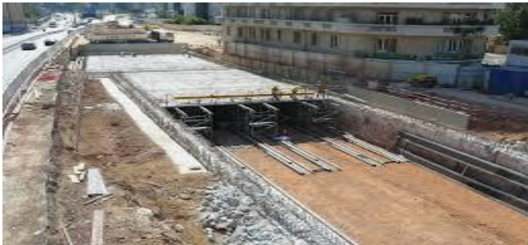
Figure II.2 : Creusement à ciel ouvert (tranchées couvertes).
