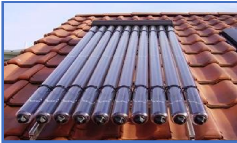
Figure ( I.8 ) : Capteur a tube sous vide[10].
