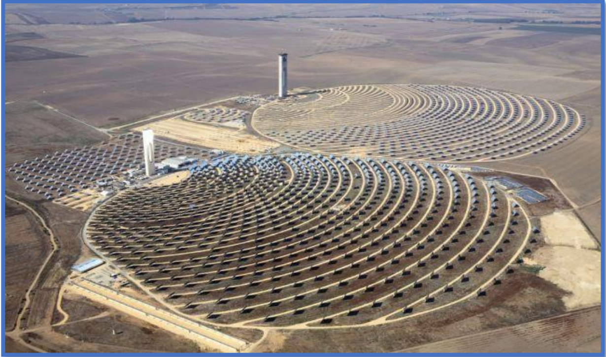
Figure ( I.10 ) : Centrale solaire thermique en Espagne[12].
