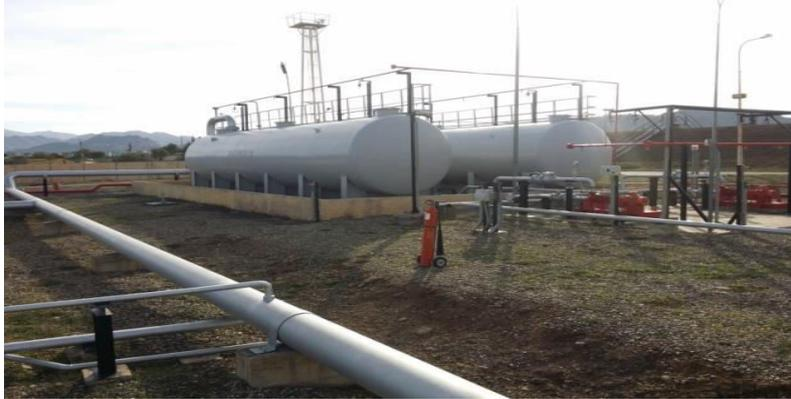
**Figure II.11 :** Les deux cuves de purges.
