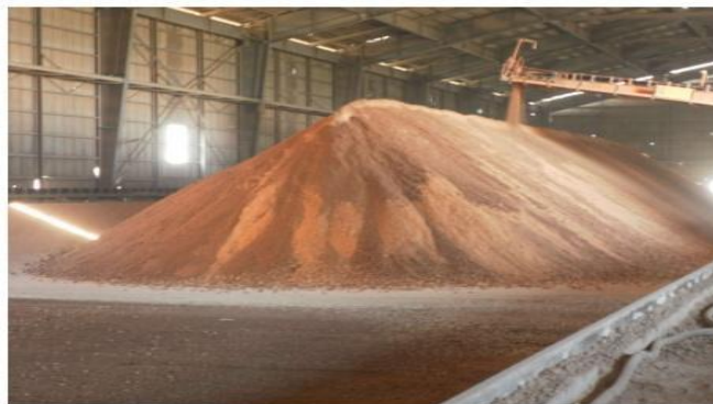
Figure III.3 : Hall de pré homogénéisation
