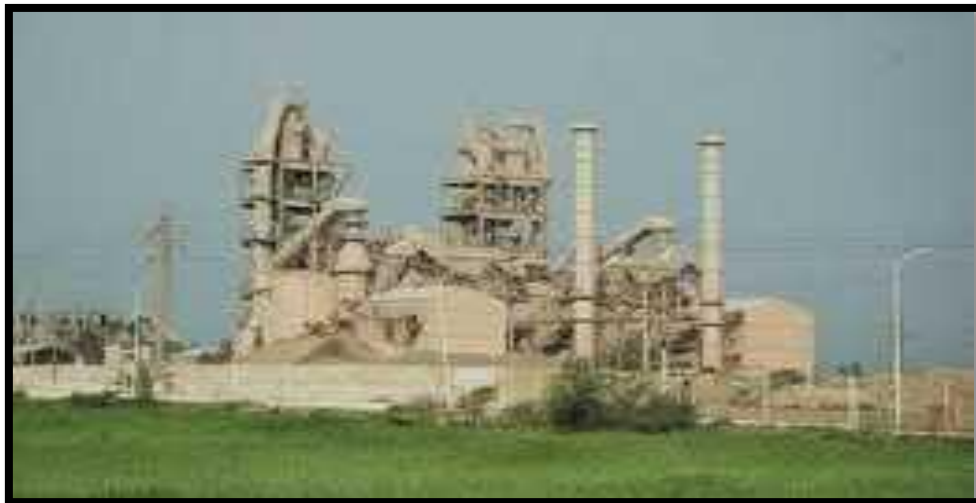
Figure. I.1: Vue d'ensemble de la cimenterie de Chlef.
