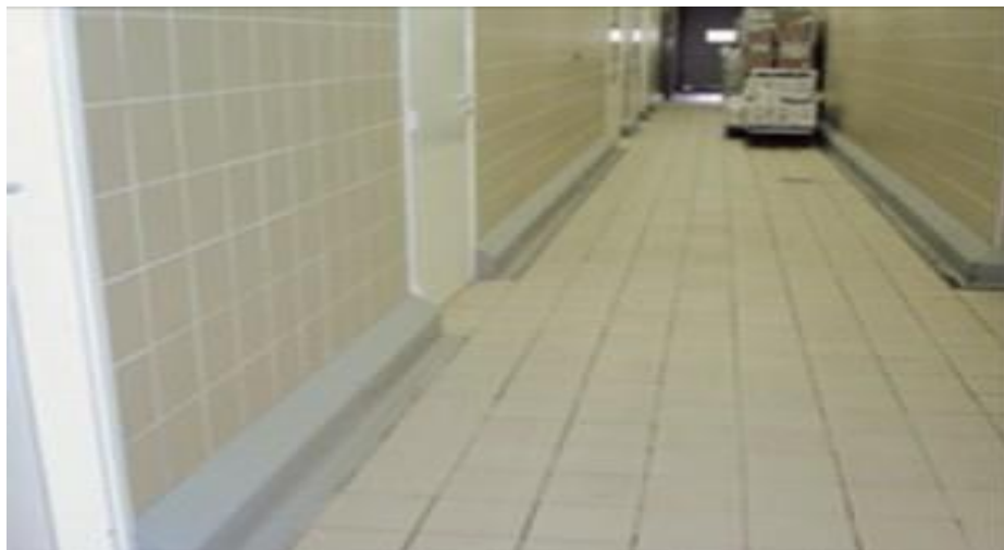
Figure IX : Murs d'un établissement de restauration collective (INRS, 2010)
