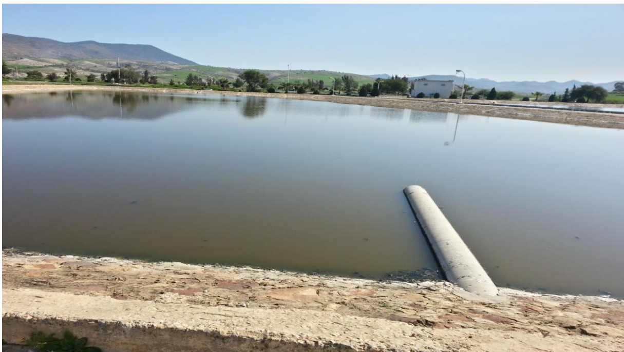
Fig. 1.10 : Bassin de décantation.
