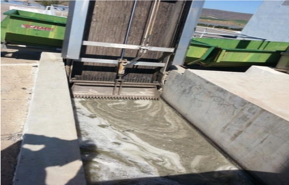
Fig. 1.6 : Dégrilleur.
