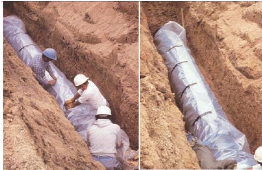
Figure 23 : Protection contre la corrosion extérieure avec revêtement en polyéthylène
