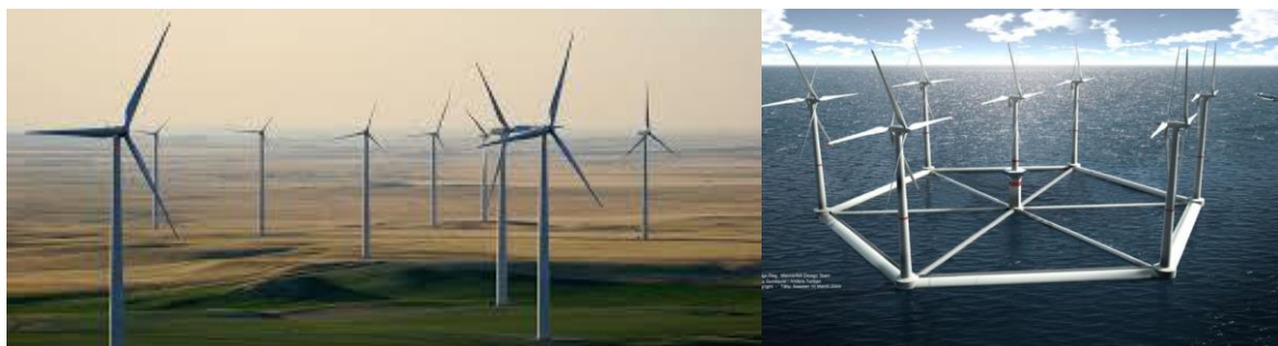
Figure (I.6): fermes d'éoliennes. [27]
