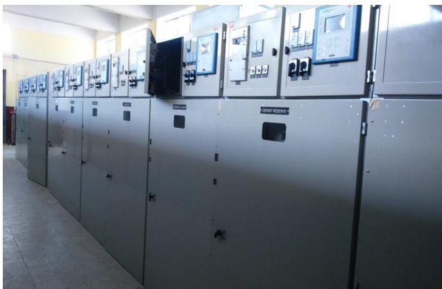
Figure 4-3 : Cellules des départs 30 KV du poste THAMEUR
