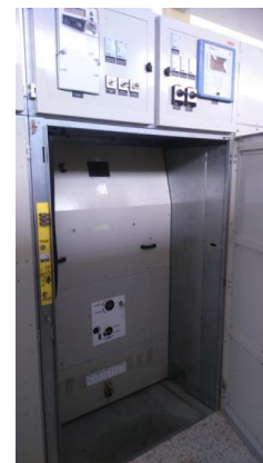
Figure 4-3 : Cellules des départs 30 KV du poste THAMEUR
