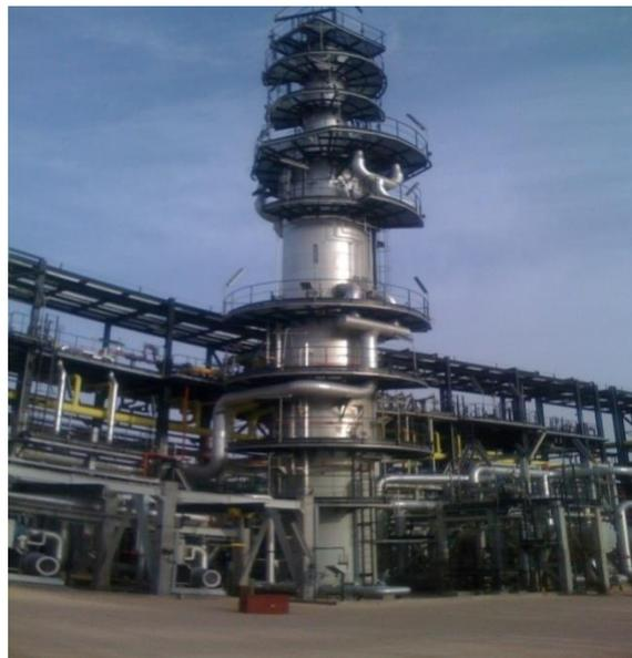
**Figure I.12** : Colonne de stabilisation
