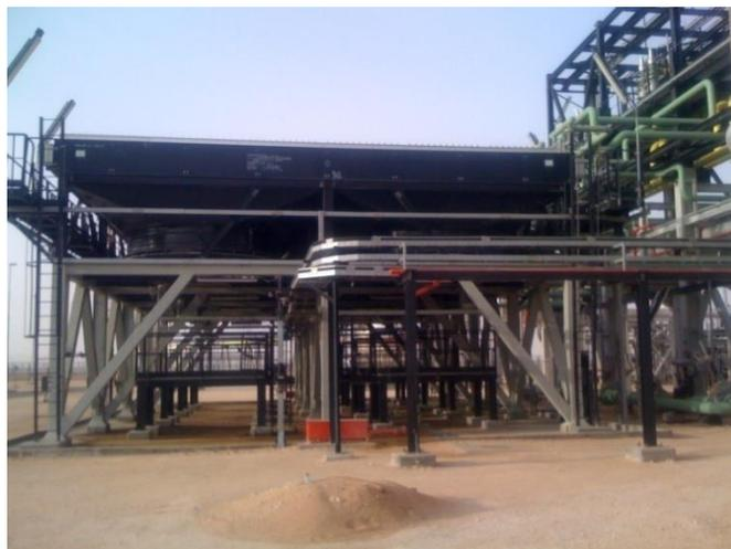
**Figure I.15** : Aéro-réfrigérants
