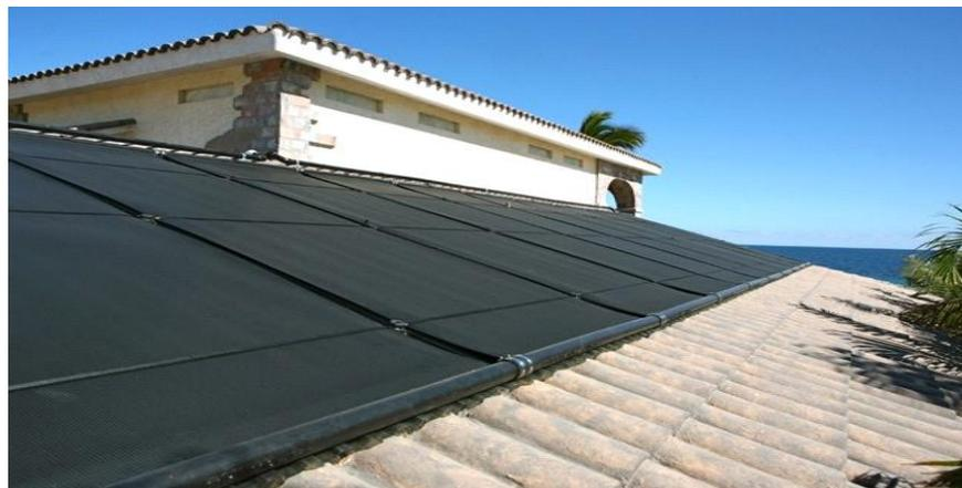
**Figure III.8** : Capteur plan non vitré.
