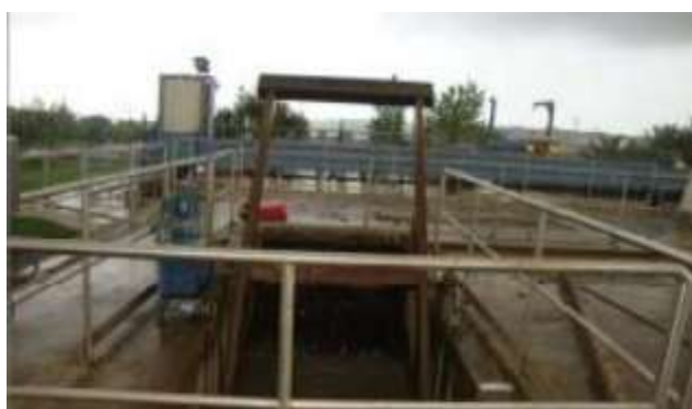
Figure 13: le dégrilleur automatique. (Benkadi et Lezoul,2017)
