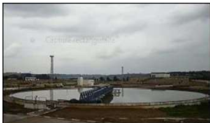
Figure 16: le décanteur primaire(Benkadi et Lezoul, 2017)
