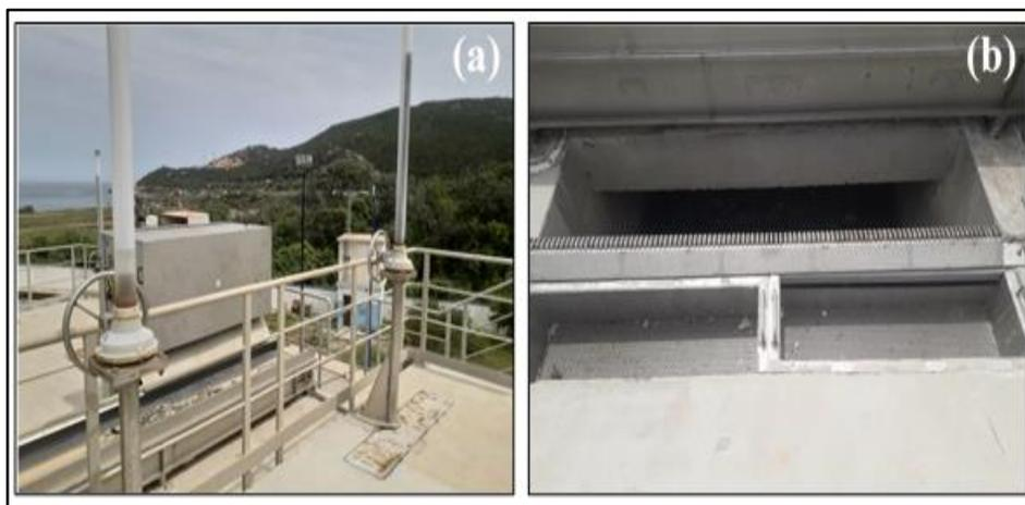
**Figure II. 5 :** Dégrilleurs : (a) Mécanique ; (b) Manuelle.
