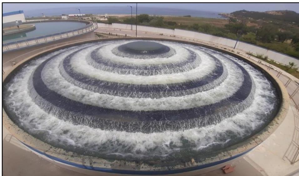
**Figure II. 6 :** Cascade d'aération.
