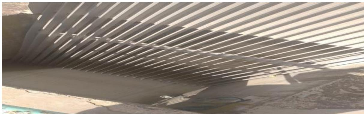
Figure III. 1: Dégrilleur mécanique de la STEP de Médéa
