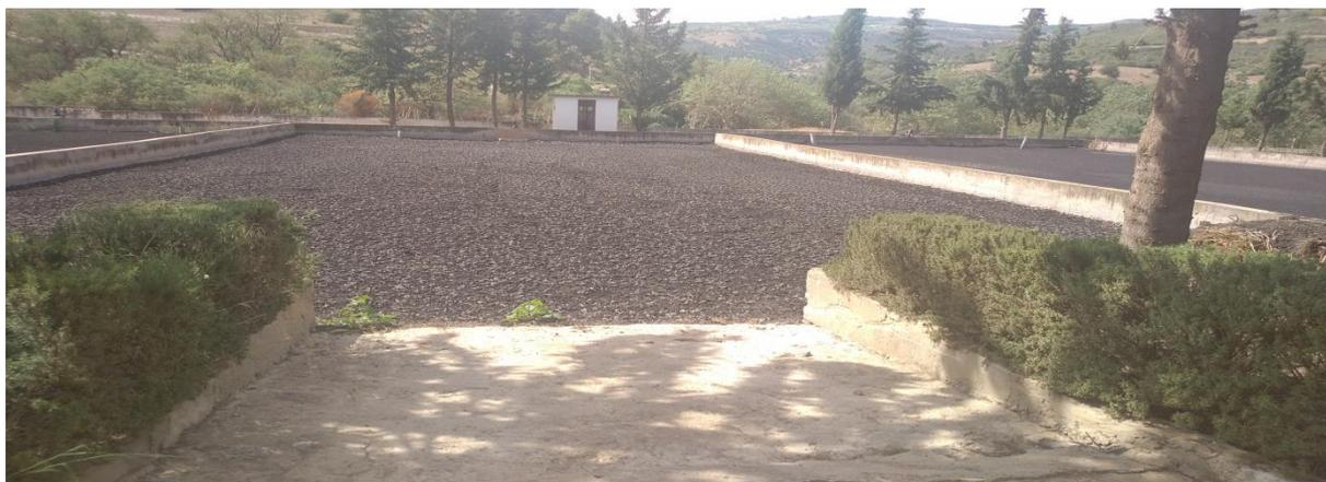
Figure III. 8: Lits de séchage de la STEP de Médéa
