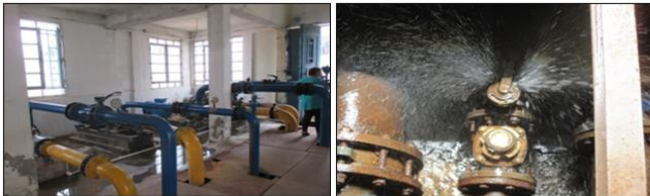
Figure 4: Vue d'intérieur de la Station de pompage et l'état de la conduite de refoulement
