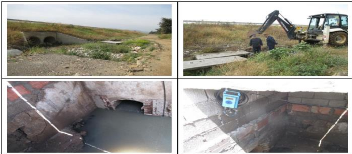
Figure 21 Point N°01 Buse DN600 béton.
