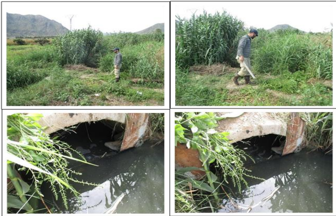
Figure 31 Point N°05 Buse DN1200 béton (Chaabat N°04)
