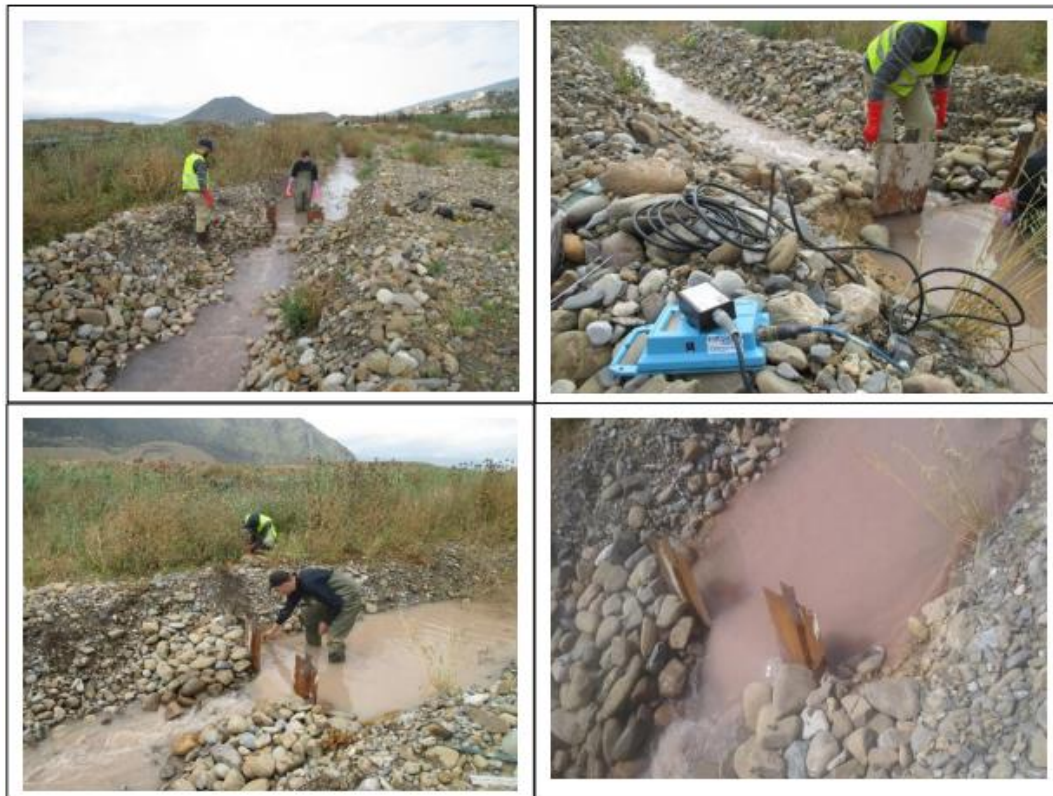
Figure 35 Point N°07 Canal en terre (Chaabat N°06)
