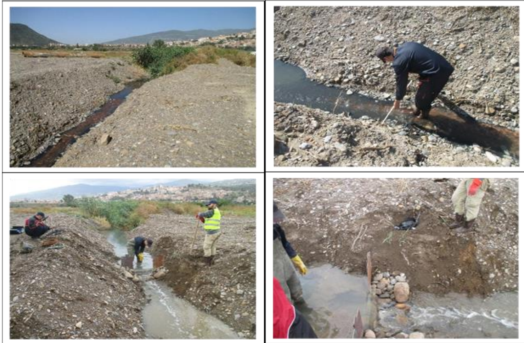
Figure 29 Point N°04 Canal en terre (Chaabat N°03)
