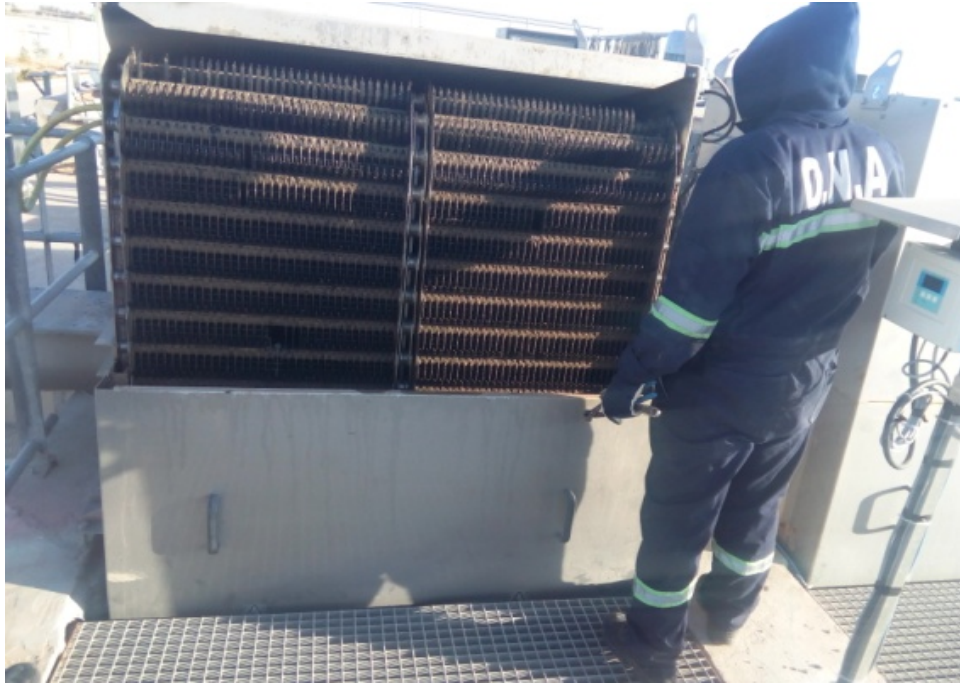
Figure III.4 : Dégrilleur manuel
