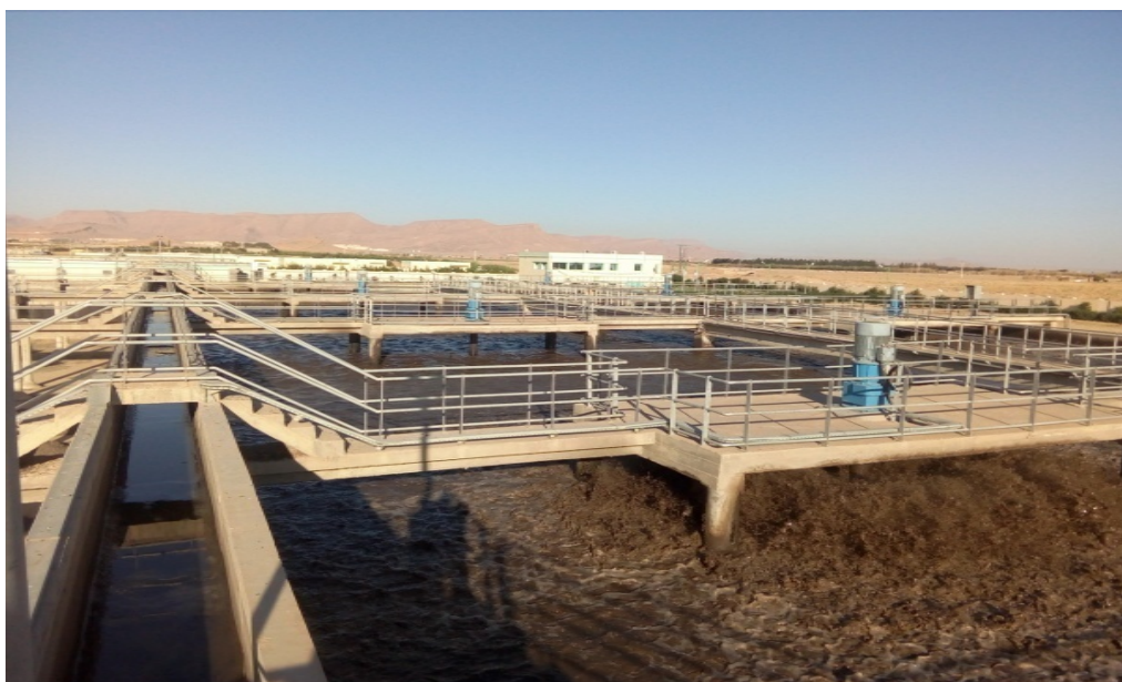
Figure III.7 : Bassin d'aération
