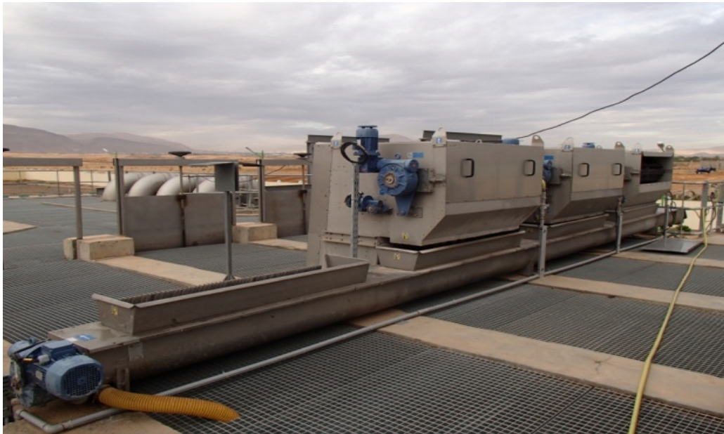
Figure III.3 : Dégrilleur fin automatique
