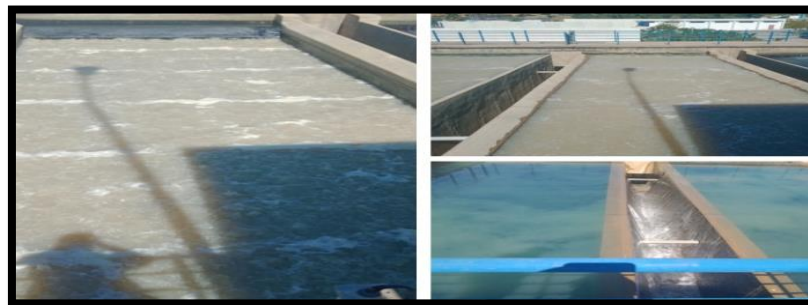
Figure I. 12: Bassins de la filtration à sable
