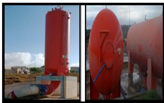
Figure IV. 5: Les réservoirs anti-bélier.
