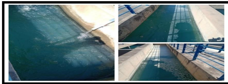
Figure I. 10: Bassins de la coagulation de la station de traitement Tilesdit
