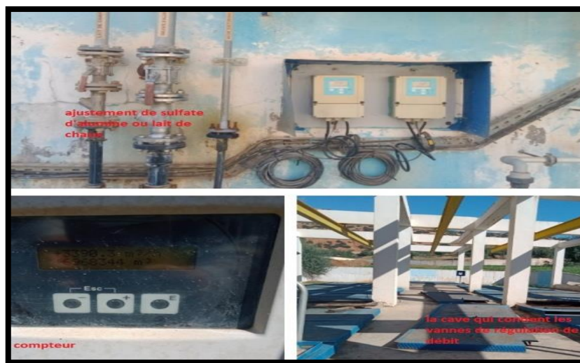
Figure I. 8: Régulation du débit d'entrée et l'ajustement de pH
