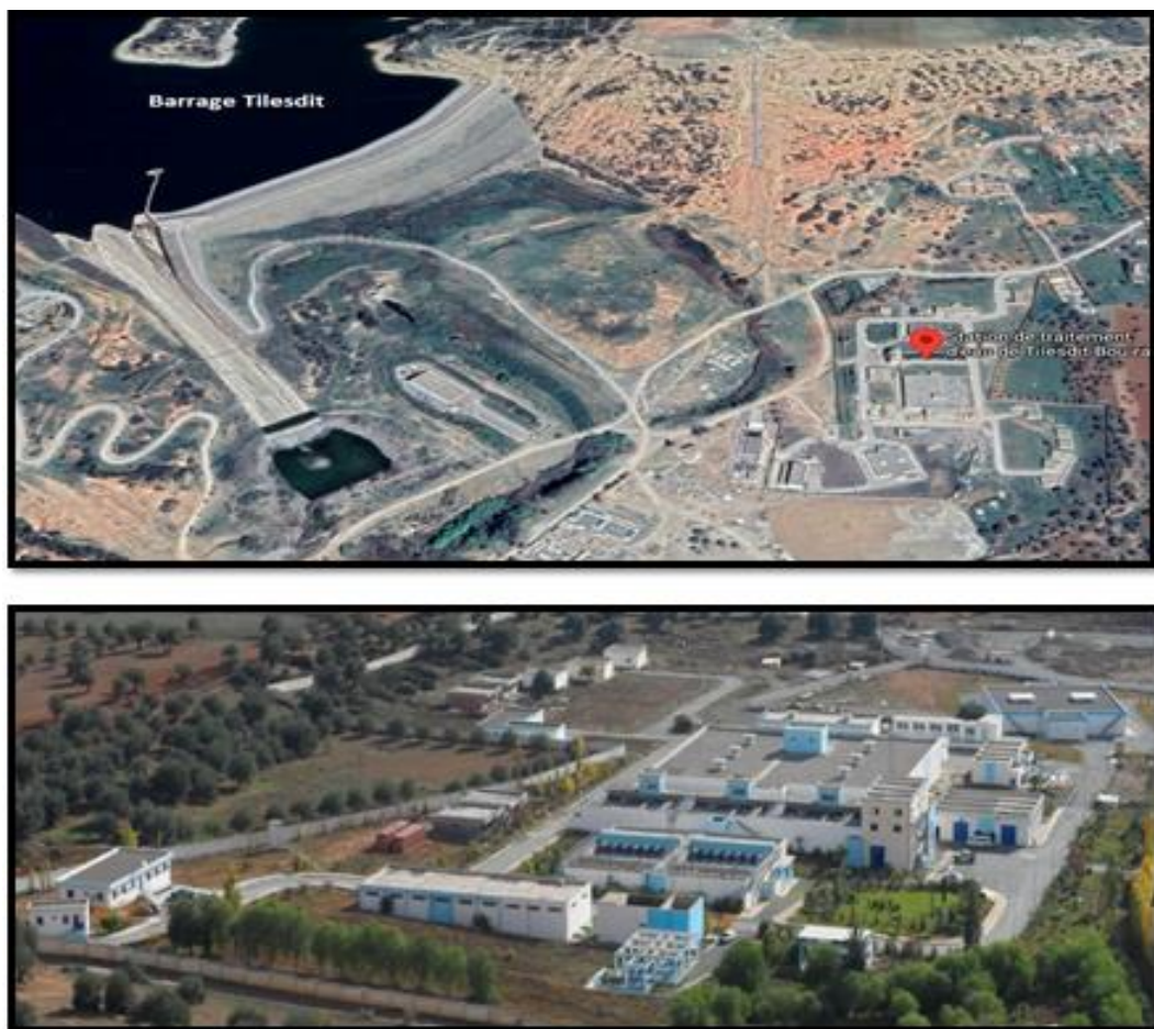
Figure I. 4: Station de traitement du barrage Tilesdit de la wilaya de bouira
