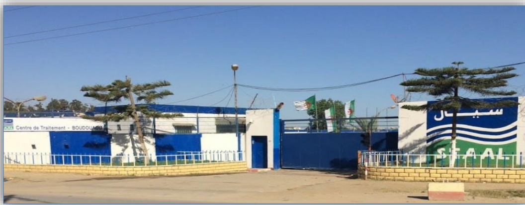
Figure II. 1: Photo centre de traitement des eaux – Boudouaou [4]
