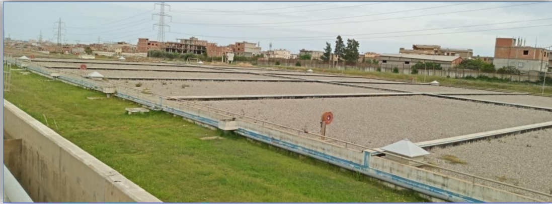
Figure II. 2: Photo réservoir du stockage
