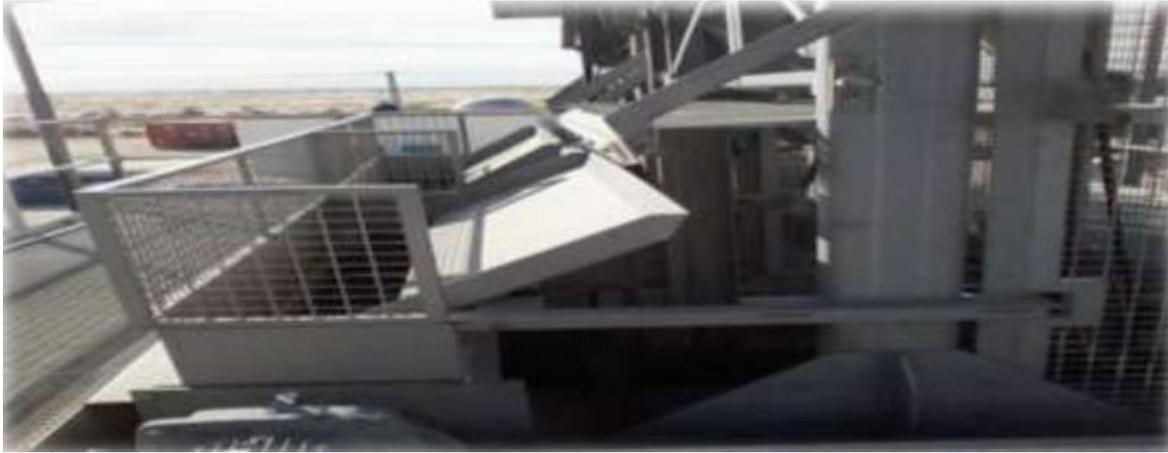
**Figure III. 9 :** Dégrillage
