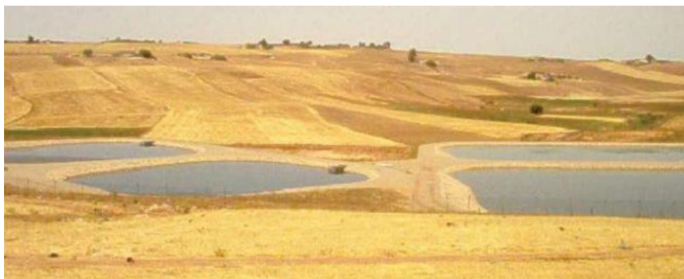
Figure III.13 : Photo de bassins de lagunage [23]
