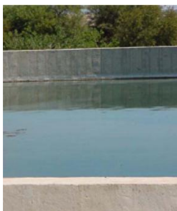
Figure III.16 : Photo lagune anaérobie [18]
