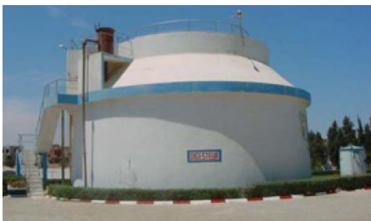
Figure III.18 : Photo d'un digesteur [20]
