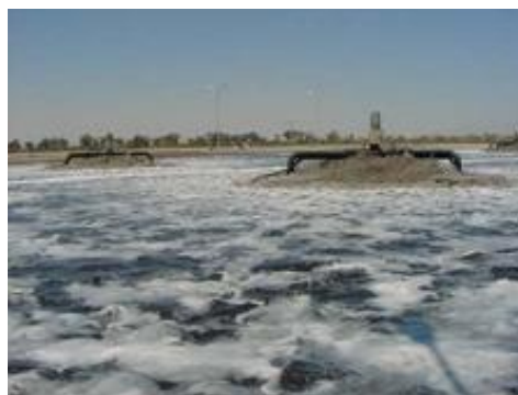
aérateurs de surface amarrés
