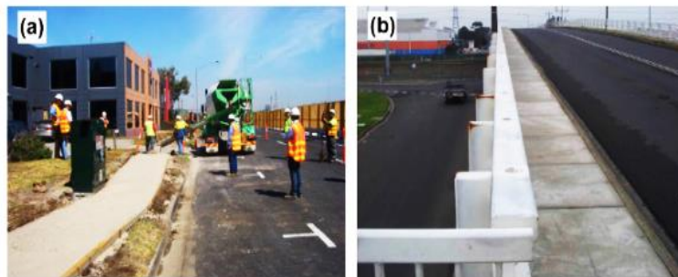
Figure I. 8 : E-Crete TM dans un port à Melbourne, Australie: a) 25MPa trottoir à travers de Westgate Freeway extension. b) 55MPa panneaux préfabriqués à travers du pont Salmon Street. (J. S. J. Van Deventer et al, 2012)
