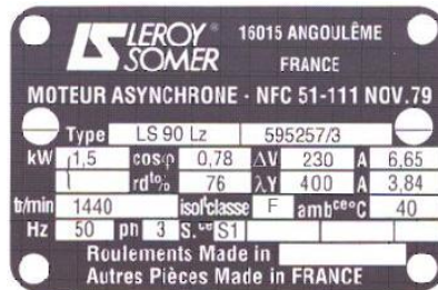
Figure (63) : plaque signalétique d'un moteur asynchrone
