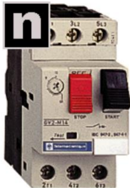
Figure (22) : disjoncteur magnétothermique [2]
