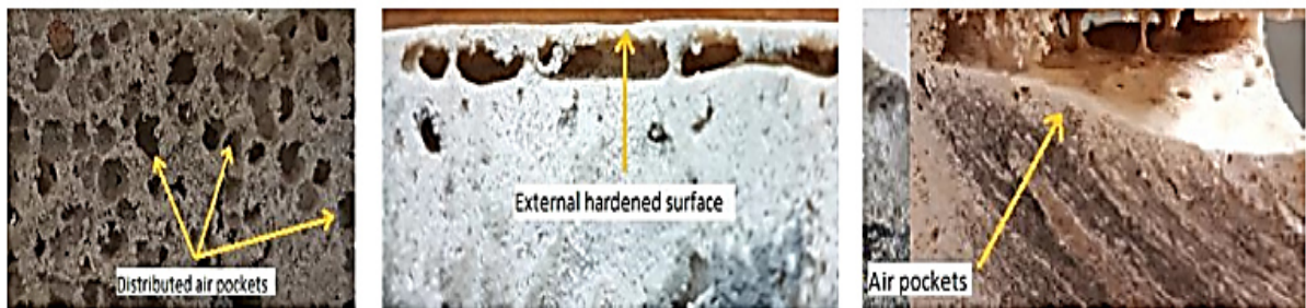
Figure III. 13 : Les vides d'air et les problèmes de durcissement de la surface externe Mortier EPS.
