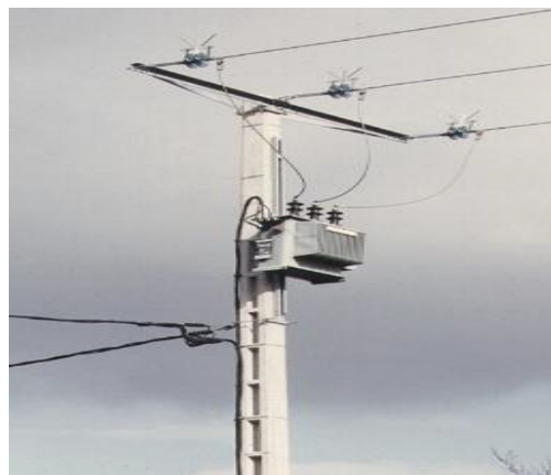
Figure II.19 : Exemple de raccordement d'un poste sur poteau [30]
