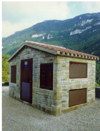
Figure II.20 : Exemple d'un poste ouvert [30]
