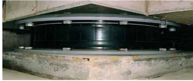
figure I.13 : Appuis en élastomère à fort taux d'amortissement
