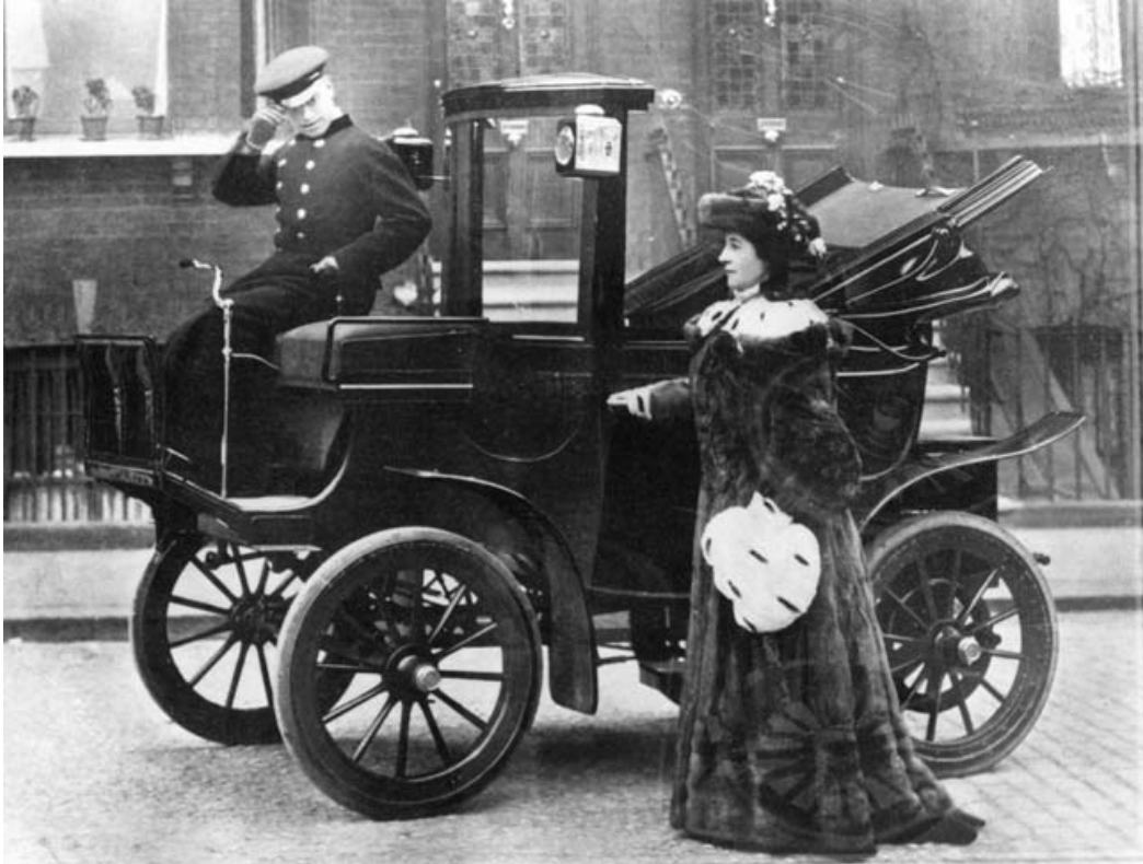
FIGURE 2.1: Un véhicule électrique à batterie de 1901
