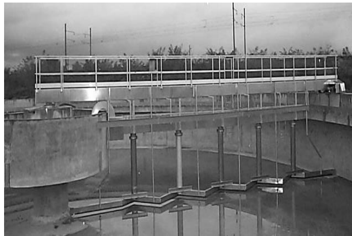
Figure II.7 : Clarificateur à pont suceur.
