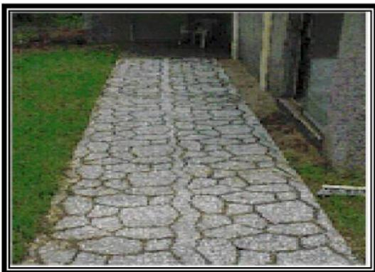
**Figure II-36.** Pavé en béton de PSE.
