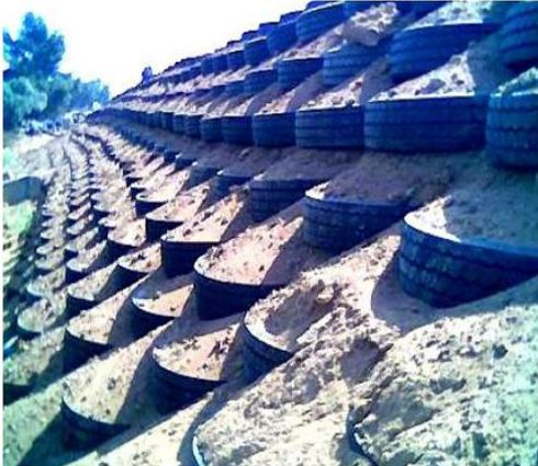
**Figure I-11** Pose des nappes de pneus
