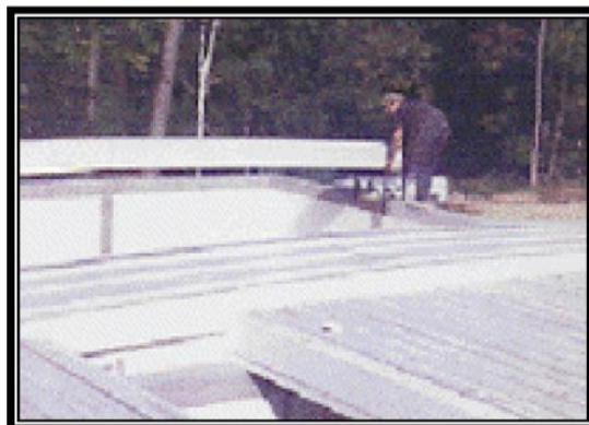
**Figure II-39.** Installation d'un plancher
