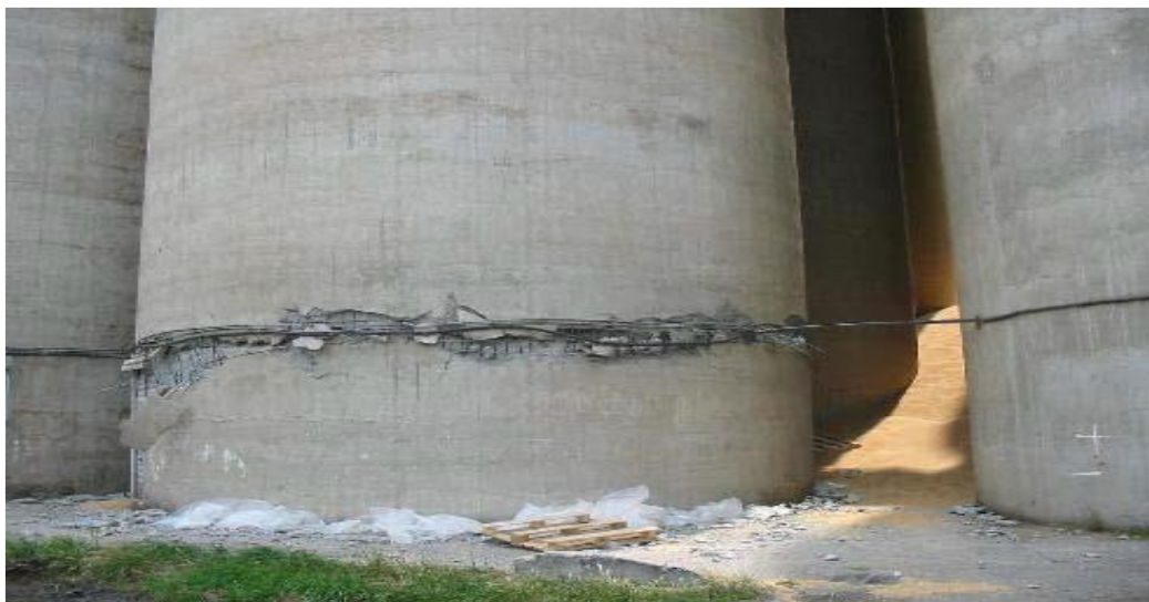
Figure 3. 4: Vue de la batterie des silos endommagée et la batterie mitoyenne (AFPS 2003)
