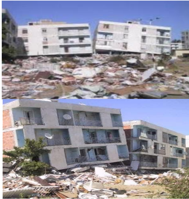
Figure 3. 5: Cité des 1200 logements à Boumerdes «Bâtiments avec poteaux, poutres et murs en maçonnerie : comportement aléatoire » (Davidovici 2003)
