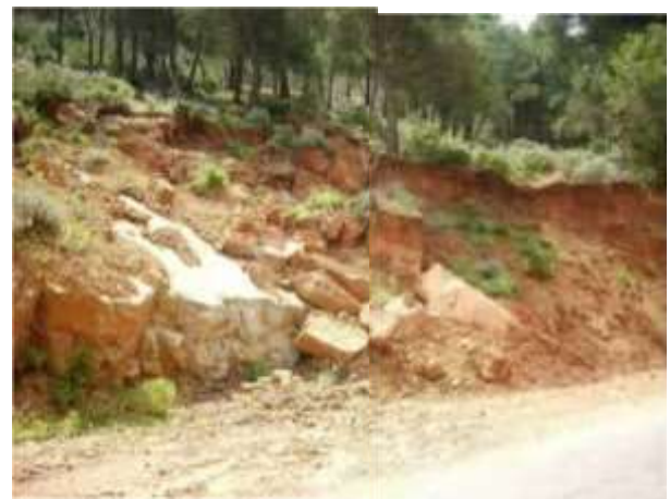
(b) : Exemple d'un glissement plan, Algérie Ténès.
