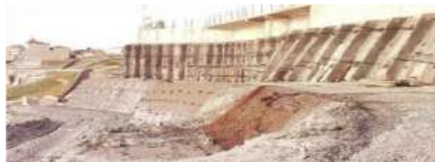
Figure I. 15: Exemple de tirants d'ancrage actif [7].
