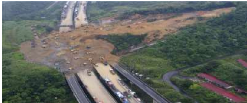
Figure I.1: vue du glissement [1].
