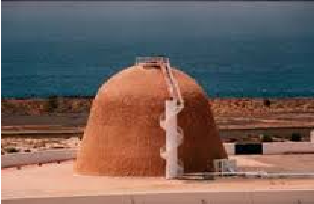
Figure II.2 : réservoir sous talus.
