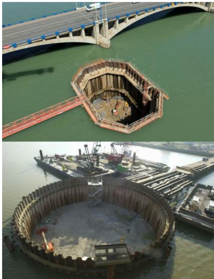
Figure I.37 : La fondation après épuisement.
