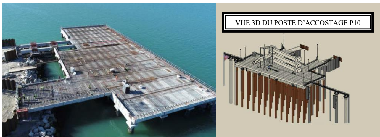
Figure II.15 : construction d'un quai pour l'accueil de ferries (pieux battus). (Nadège chabert, 2018)[40].
