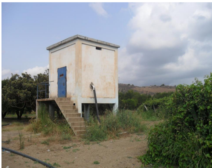
Figure. V.2 : Vue générale de l'abri de forage F2.
