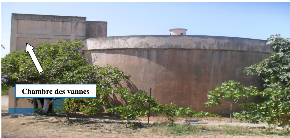
Figure. V.8 : Bache de reprise Circulaire, semi enterré 500 m 3 .
