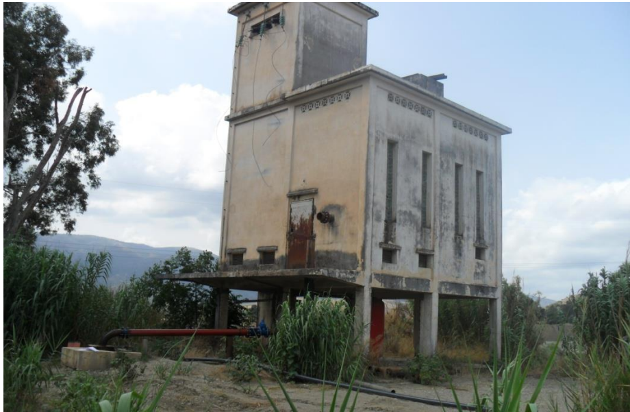
Figure. V.1: Vue générale de l'abri de forage F1.
