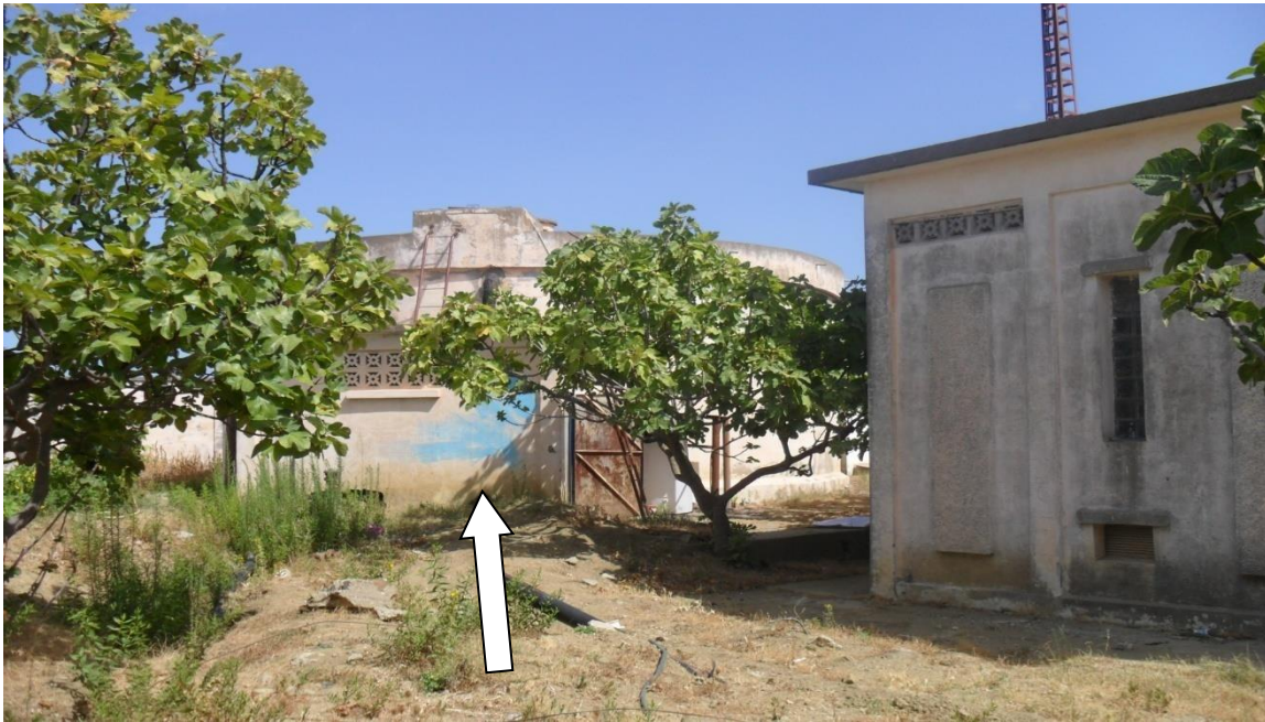
Figure. V.10 : Réservoir TAOURGA Circulaire, semi enterré 700m^3 .
